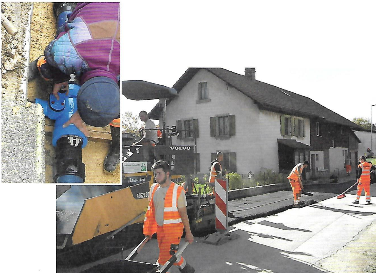
Stromversorgung, Wasserleitung und Strassenbelag werden gleichzeitig saniert.
