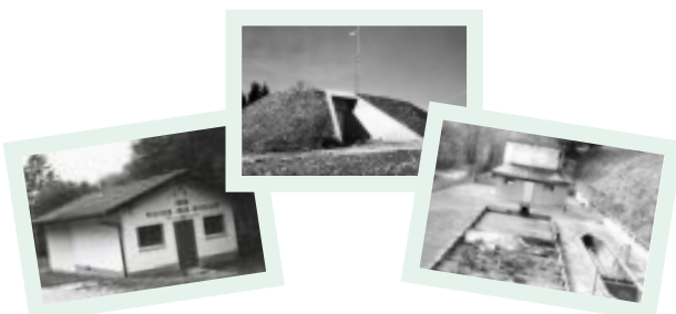
Die wichtigsten Etappen: Pumpstation, Reservoir... und ARA
